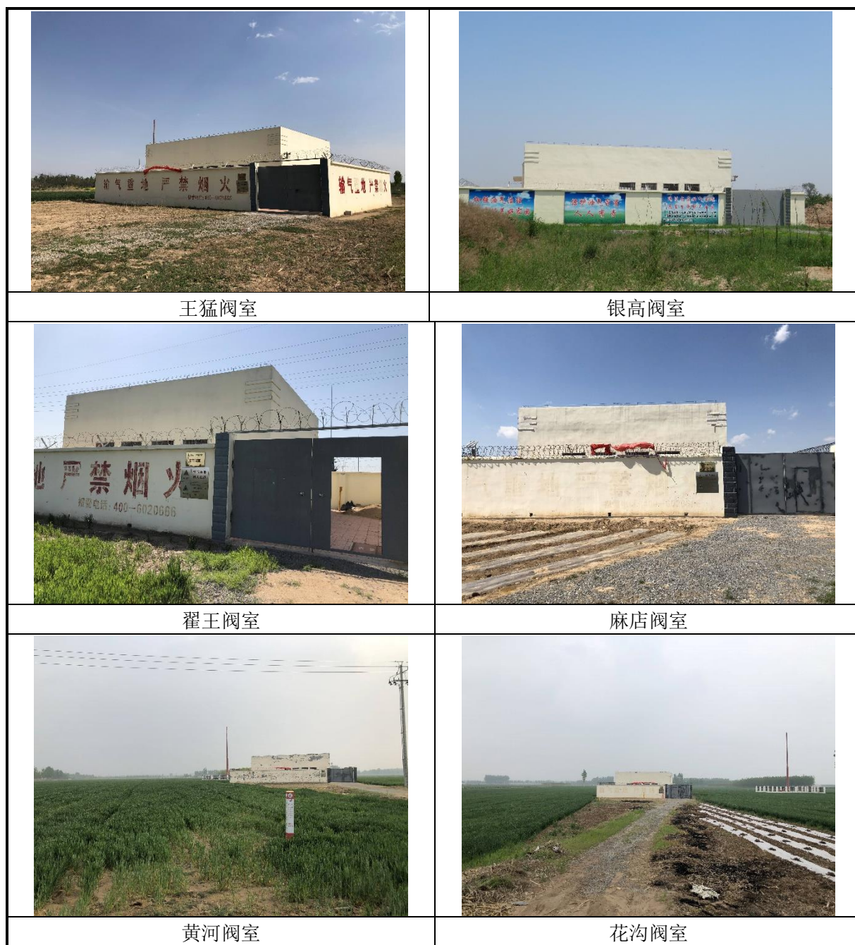
图 2.2-2 工程沿线阀室现场照片
