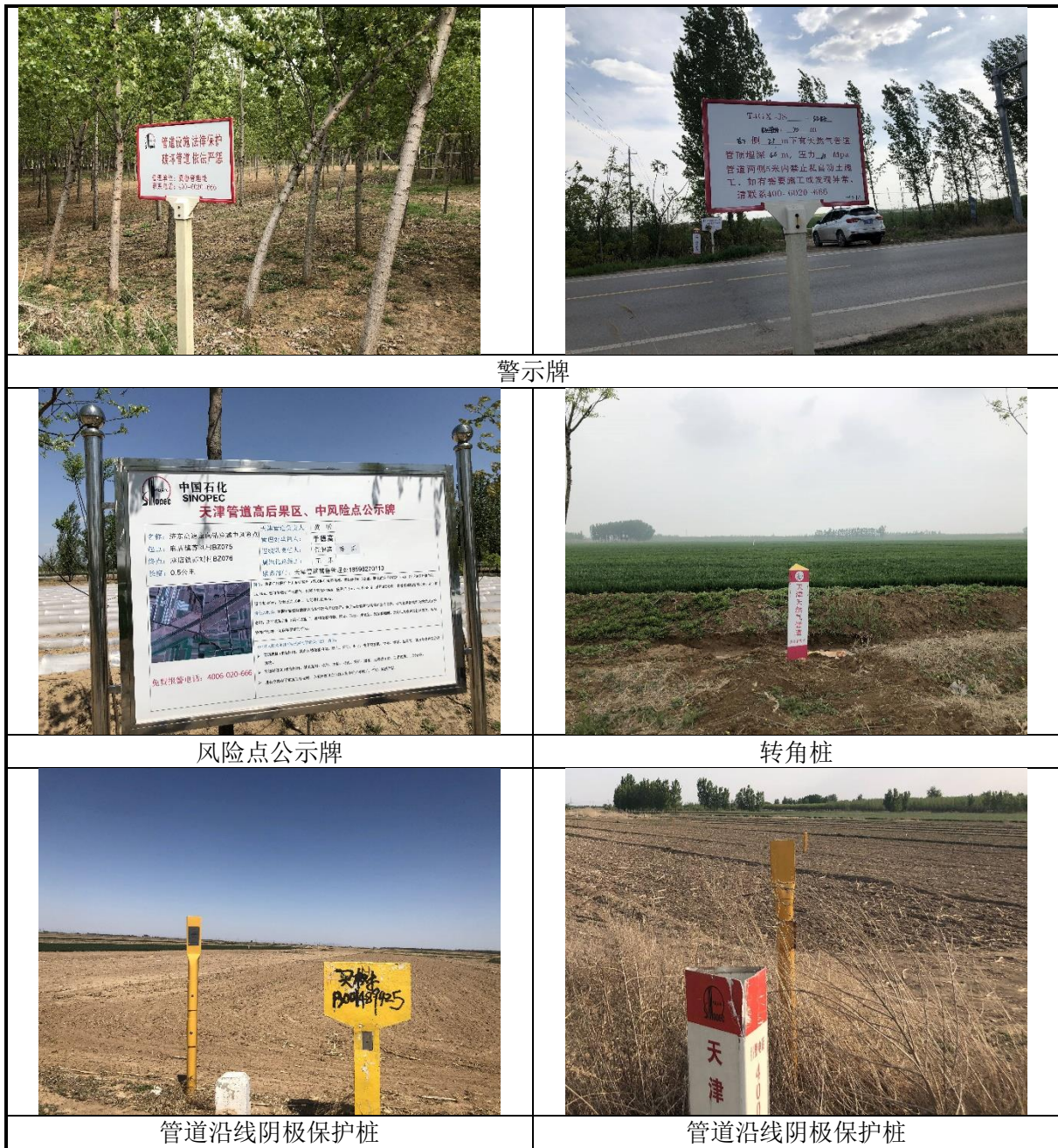
图 2.2-3 管道标志桩、转角桩、警示牌、阴极保护桩现场照片
