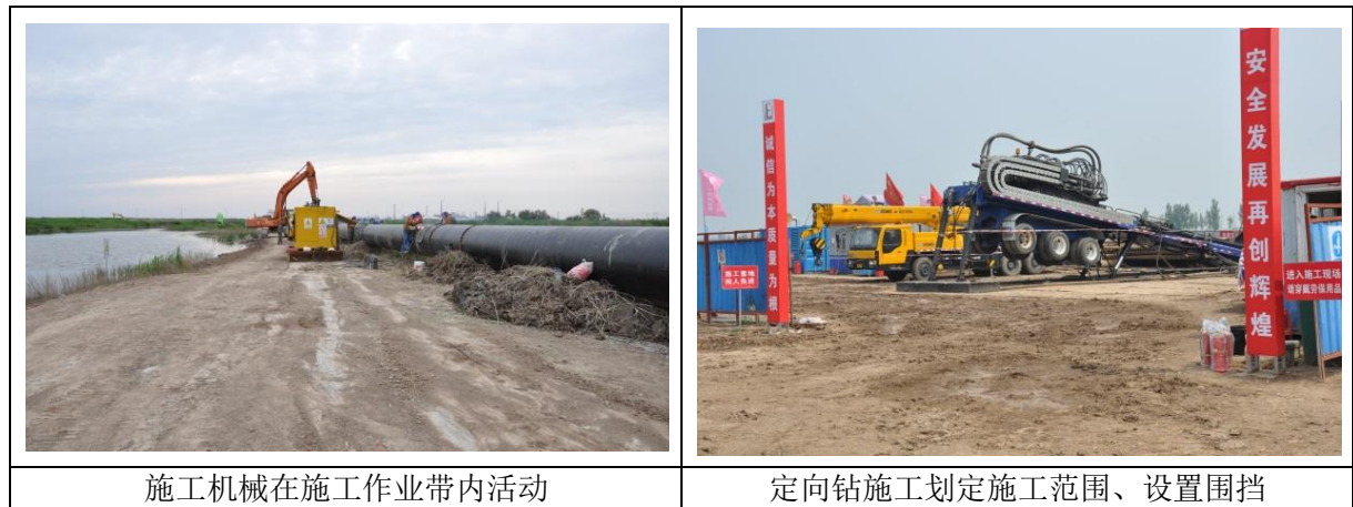
图 5.2-3 施工期生态保护措施
