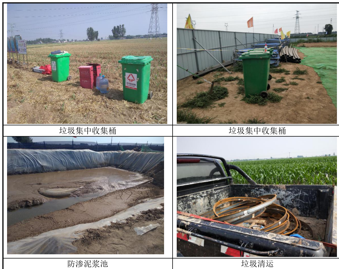
图 5.1-1 施工期垃圾集中收集及清运
