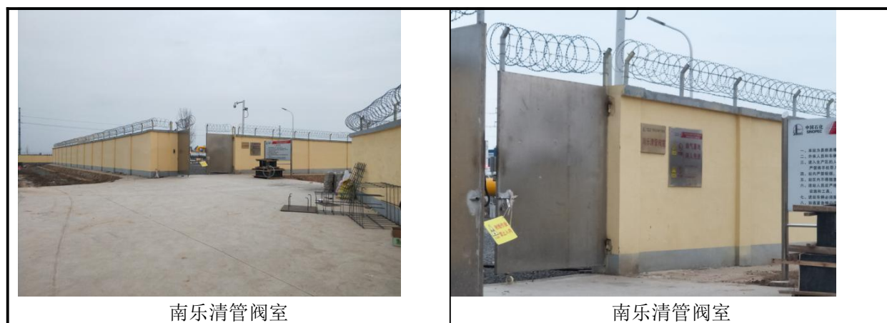
图 2.2-2 工程沿线 29 座阀室现场
