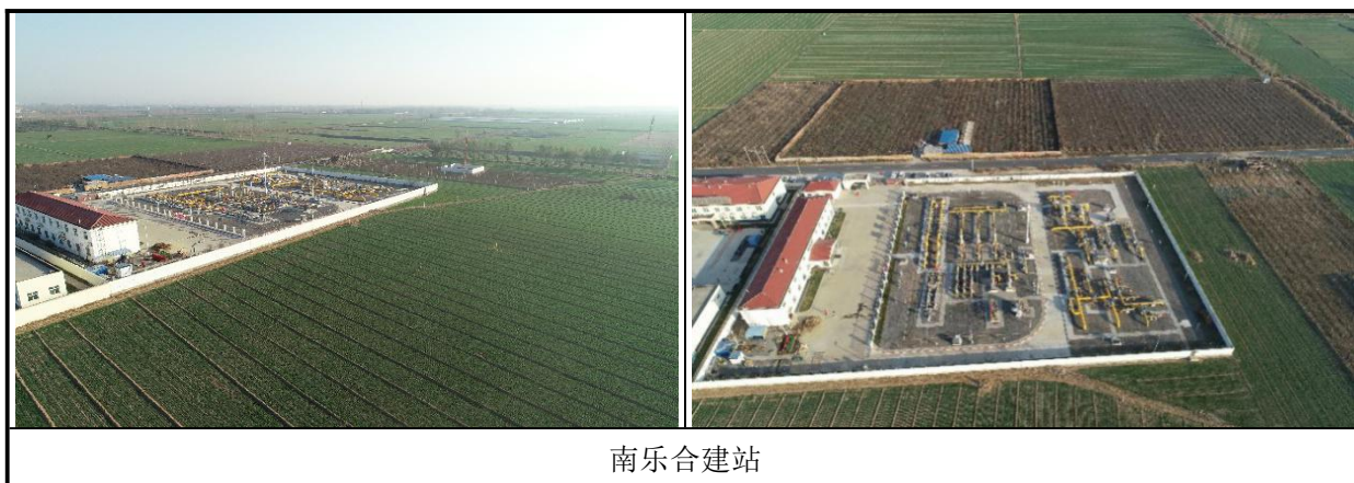
图 2.2-3 工程 9 座输气站场航拍、现场照片
