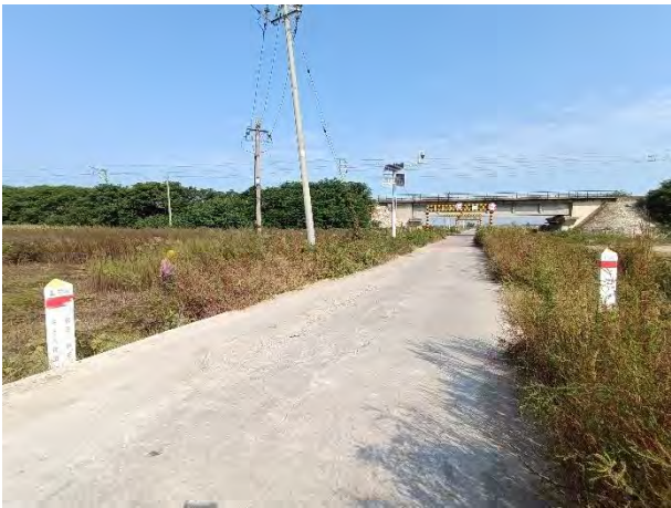
道路穿越处里程桩、标志桩、警示牌
