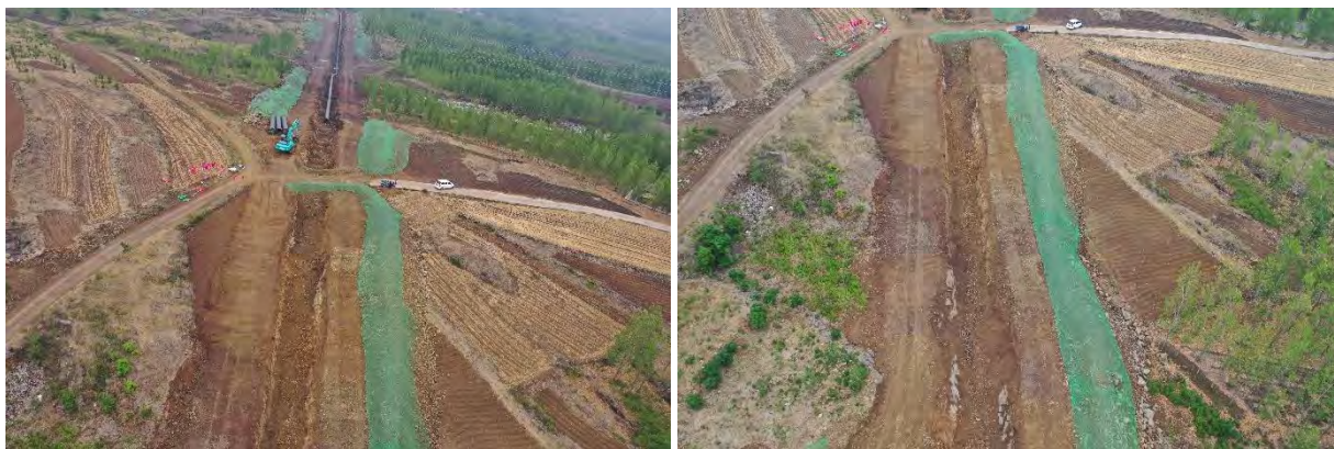
管道施工现场土方苫盖
