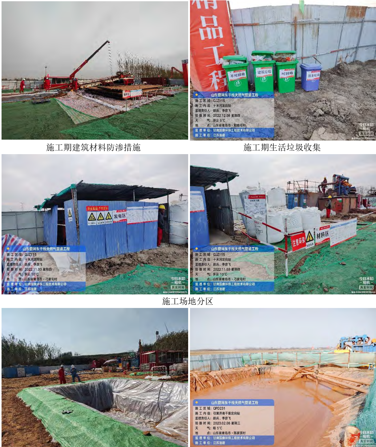
定向钻施工泥浆池进行了防渗处理 图 10.1-1 施工期垃圾污染防治措施
