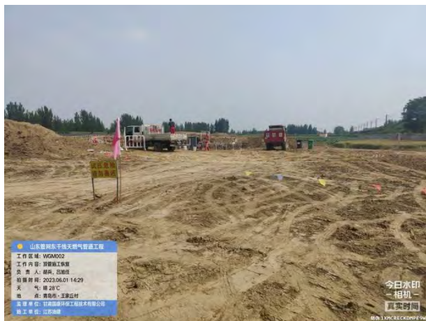
顶管现场回填
