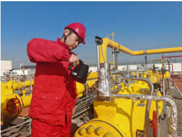
2025 年 2 月高密分输站胶州 A 支路监控调压阀指挥器冰堵现场处置演练
