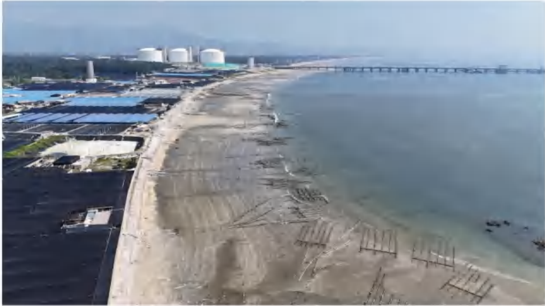
图 5.4.2-3 大埕湾沙滩排污管道、侵蚀现状
