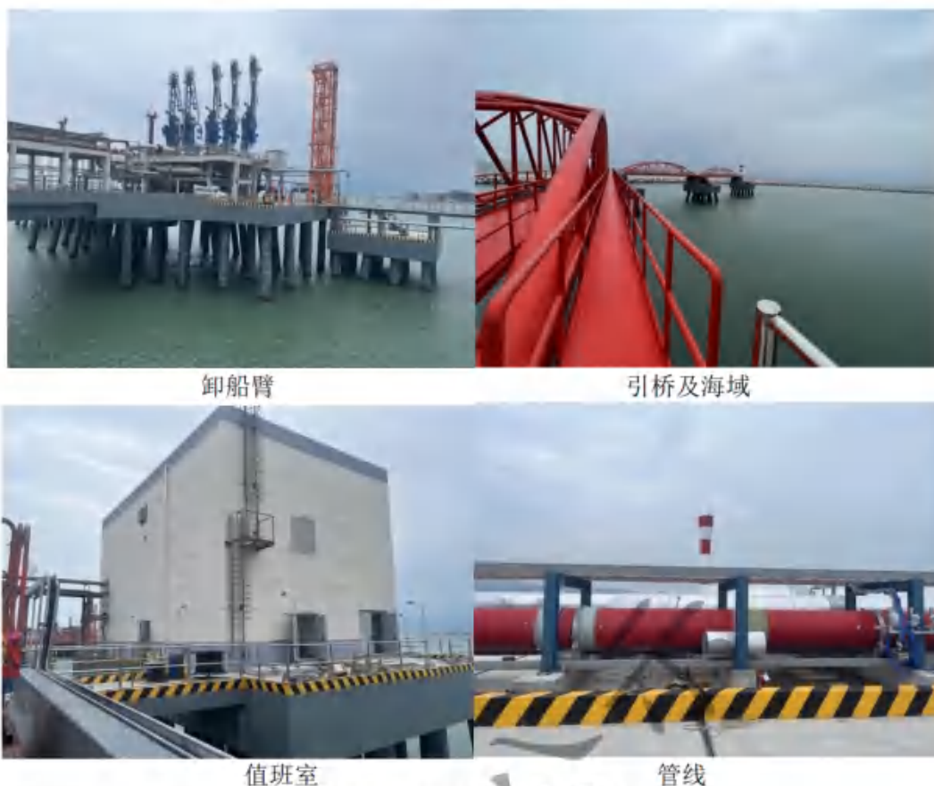
图 3.2.1-1 码头工程现场照片
